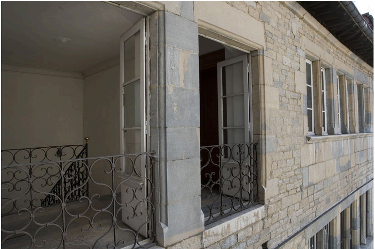
Détail de la cage de l'escalier d'honneur, depuis le premier étage de l'aile d'entrée.
