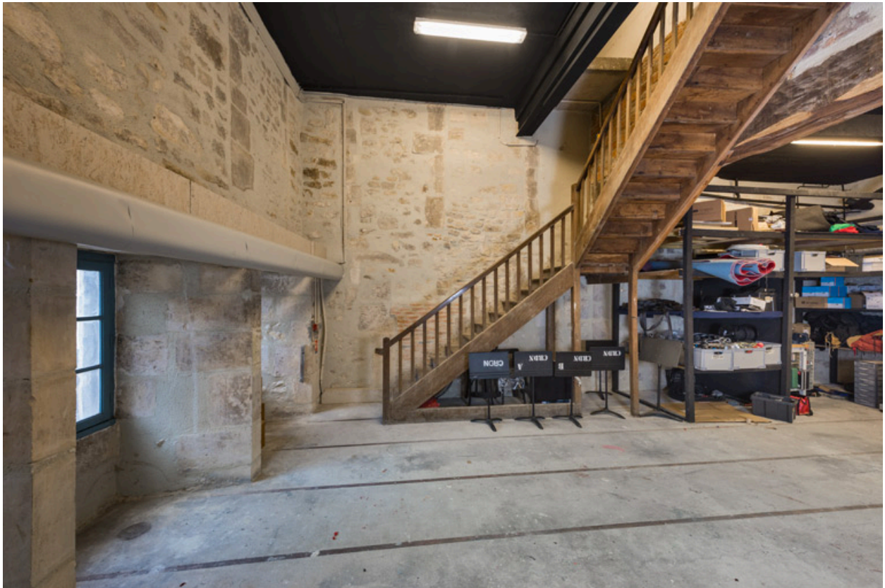
Aile orientale : magasin à l'étage de soubassement.
