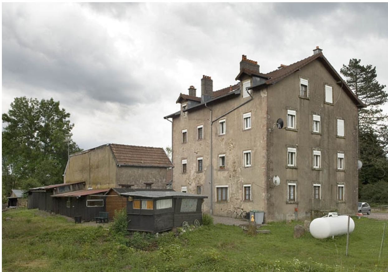
Vue d'ensemble depuis le pont.
