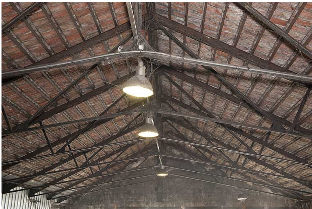
Charpente métallique d'un magasin industriel.
