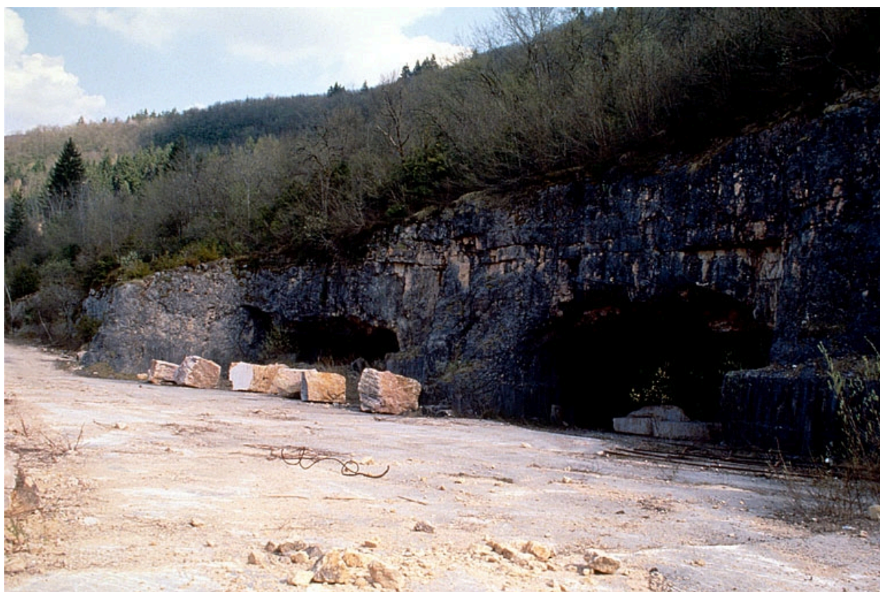
Carrière souterraine de Chassal : entrées.
