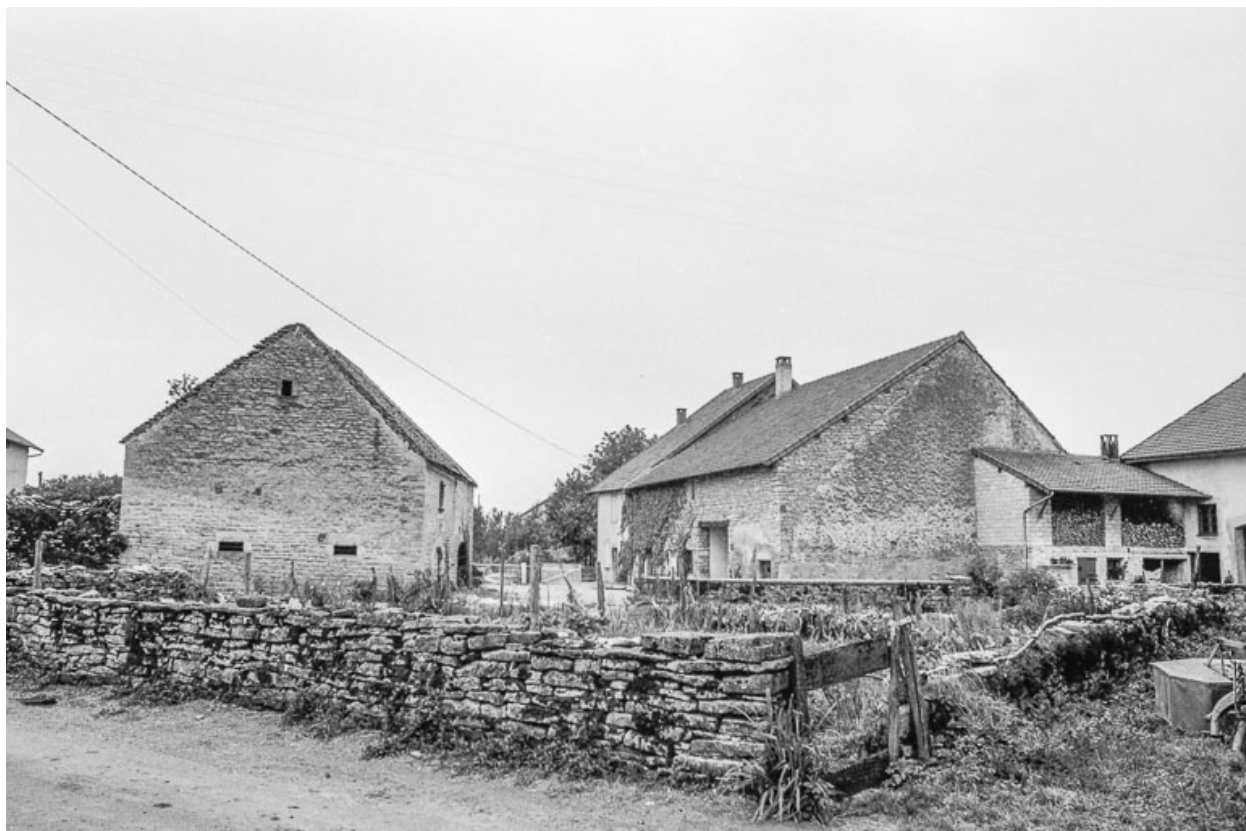
Ferme cadastrée 1951 E1 93 : vue d'ensemble.
