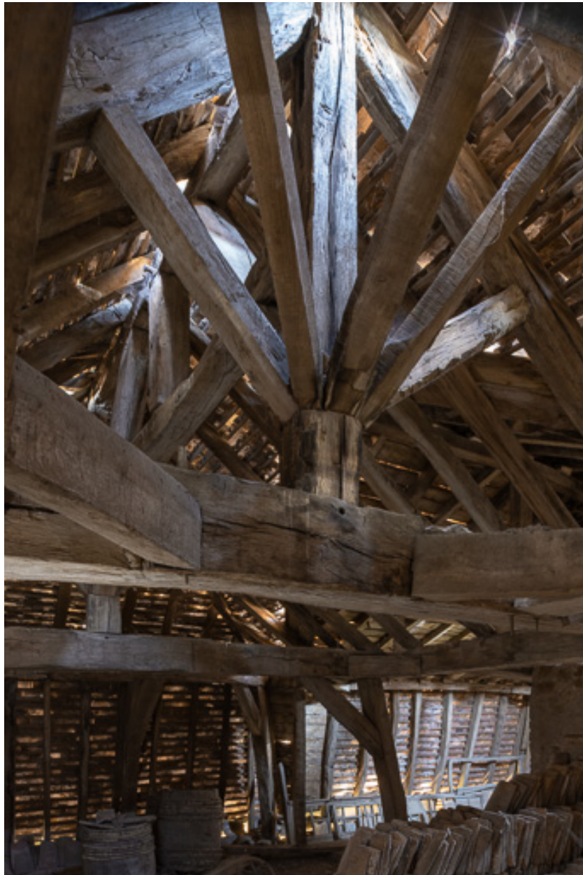
Détail de la charpente : pignon et contrefiches
