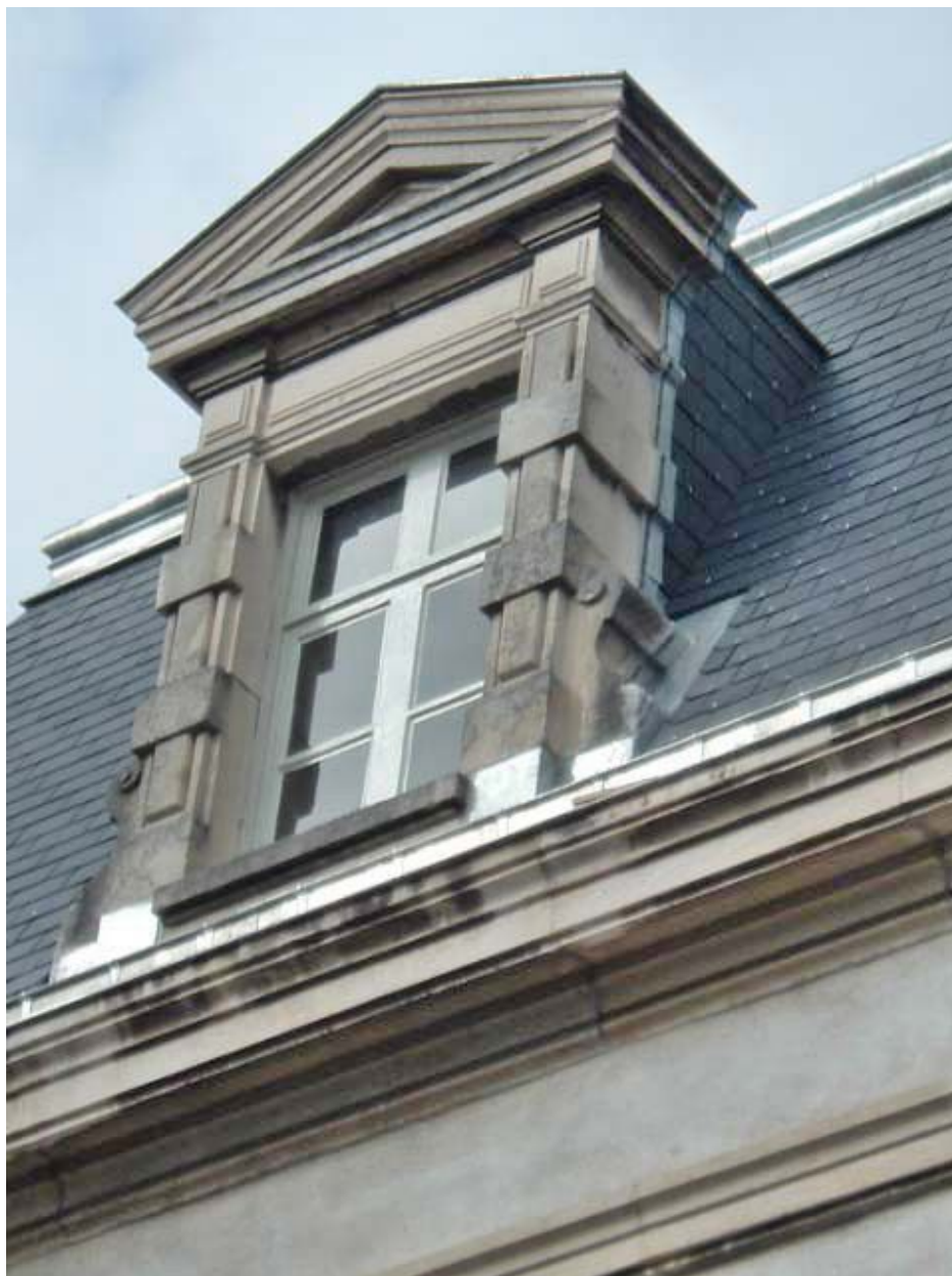
Vue de détail d'une lucarne.
