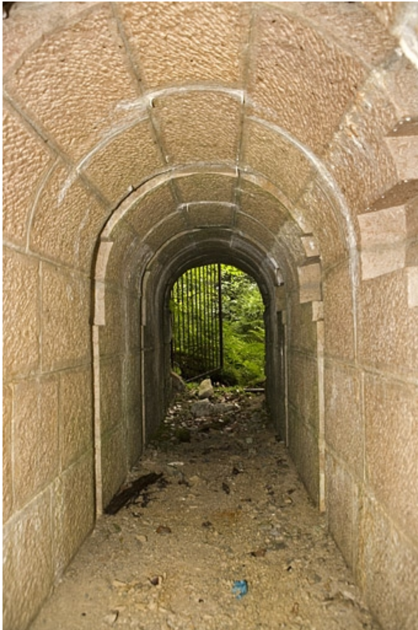
Chambres de mine sud-ouest : galerie, vue depuis le fond.
