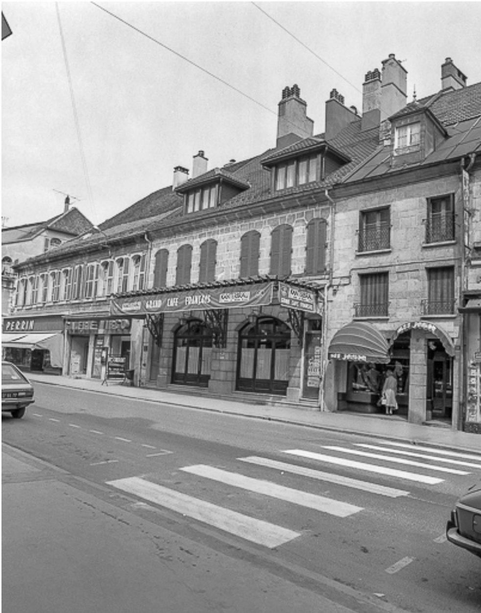
Maisons situées 34 à 38 rue de la République.
