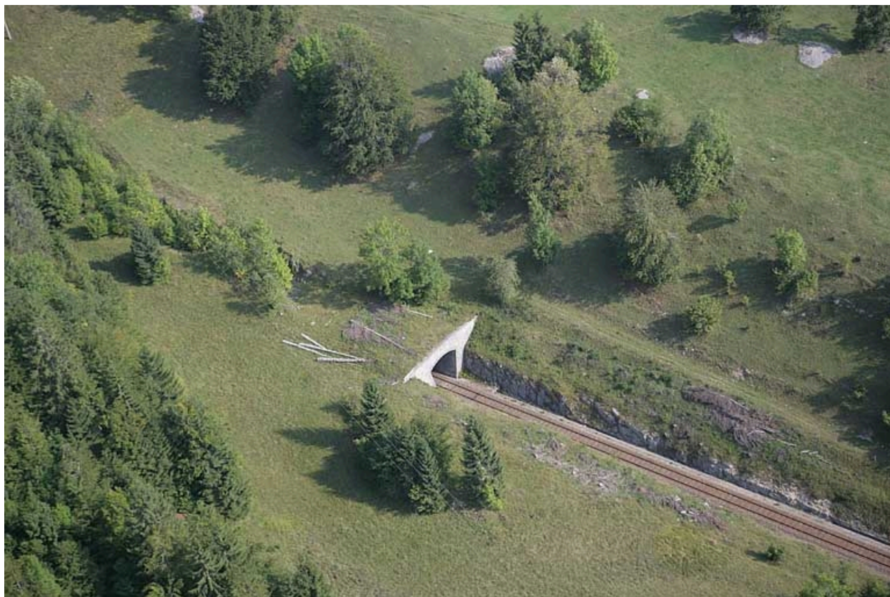
Vue aérienne rapprochée de la tête côté La Cluse, depuis le sud.
