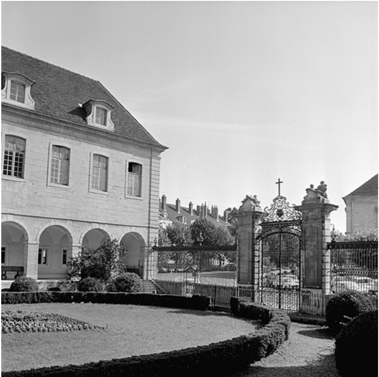
Vue postérieure de la grille fermant la cour.
