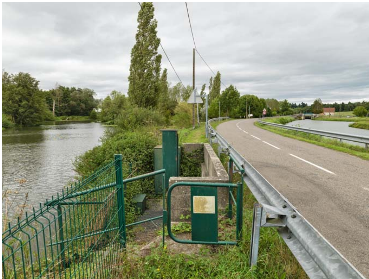
Vue de l'aqueduc.
