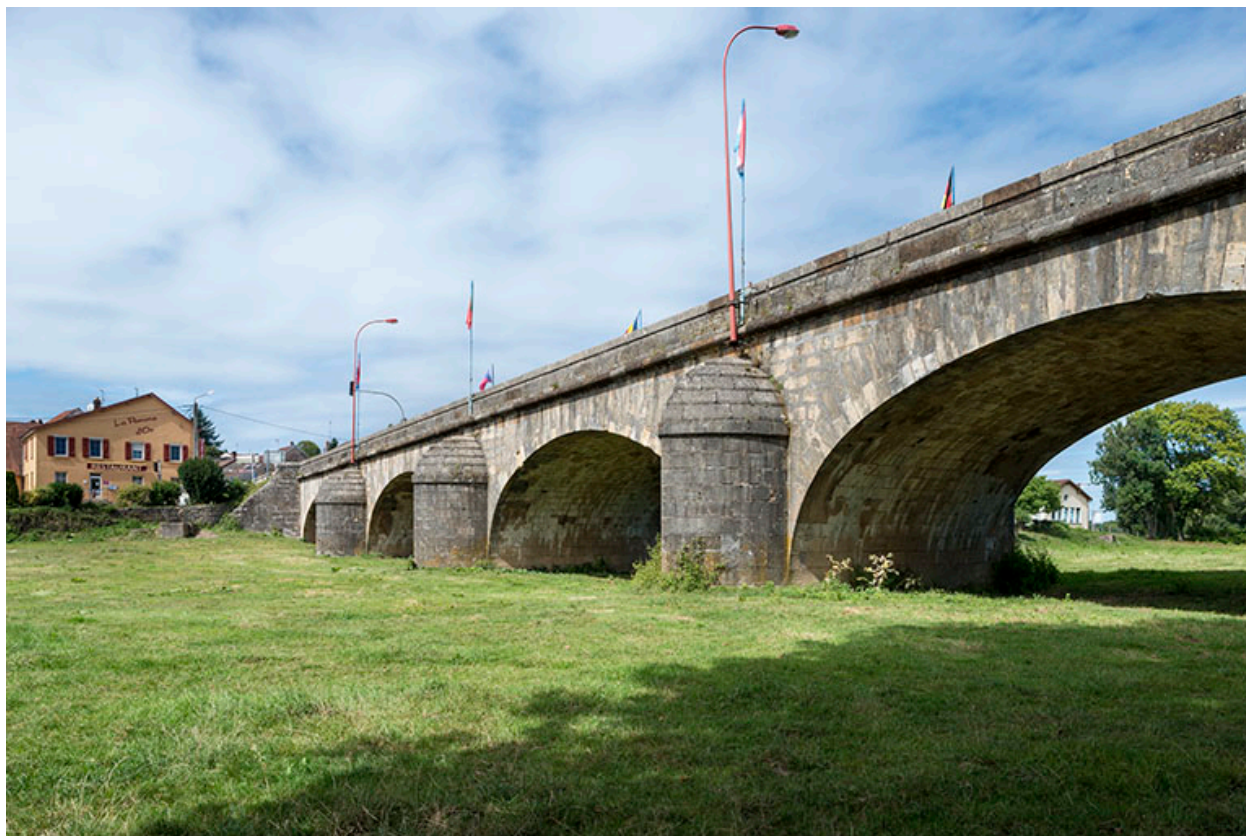
Vue depuis l'aval.
