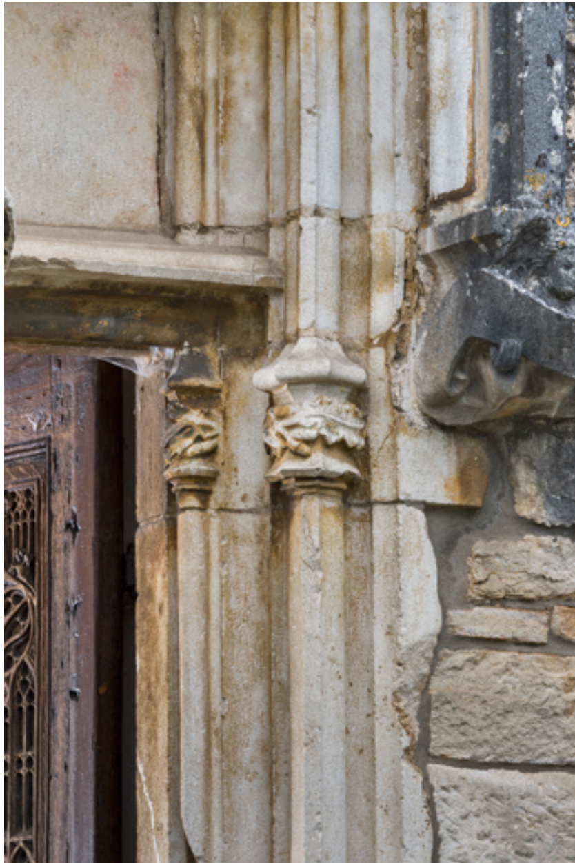
Piédroit, détail de la partie supérieure, droite.
