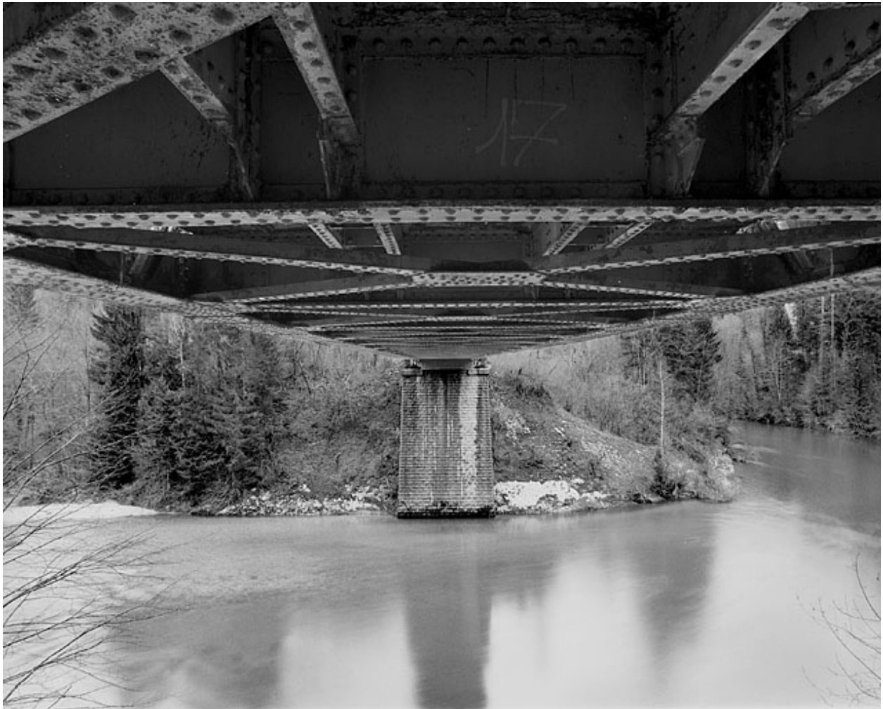
Partie inférieure du tablier et culée rive droite.
