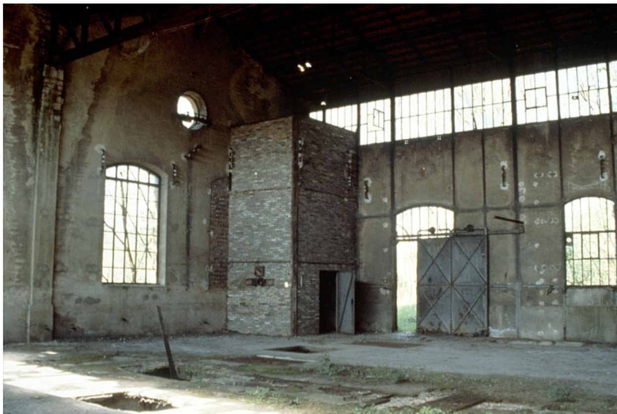
Forge Neuve. Centrale électrique : intérieur de la salle des machines (J).
