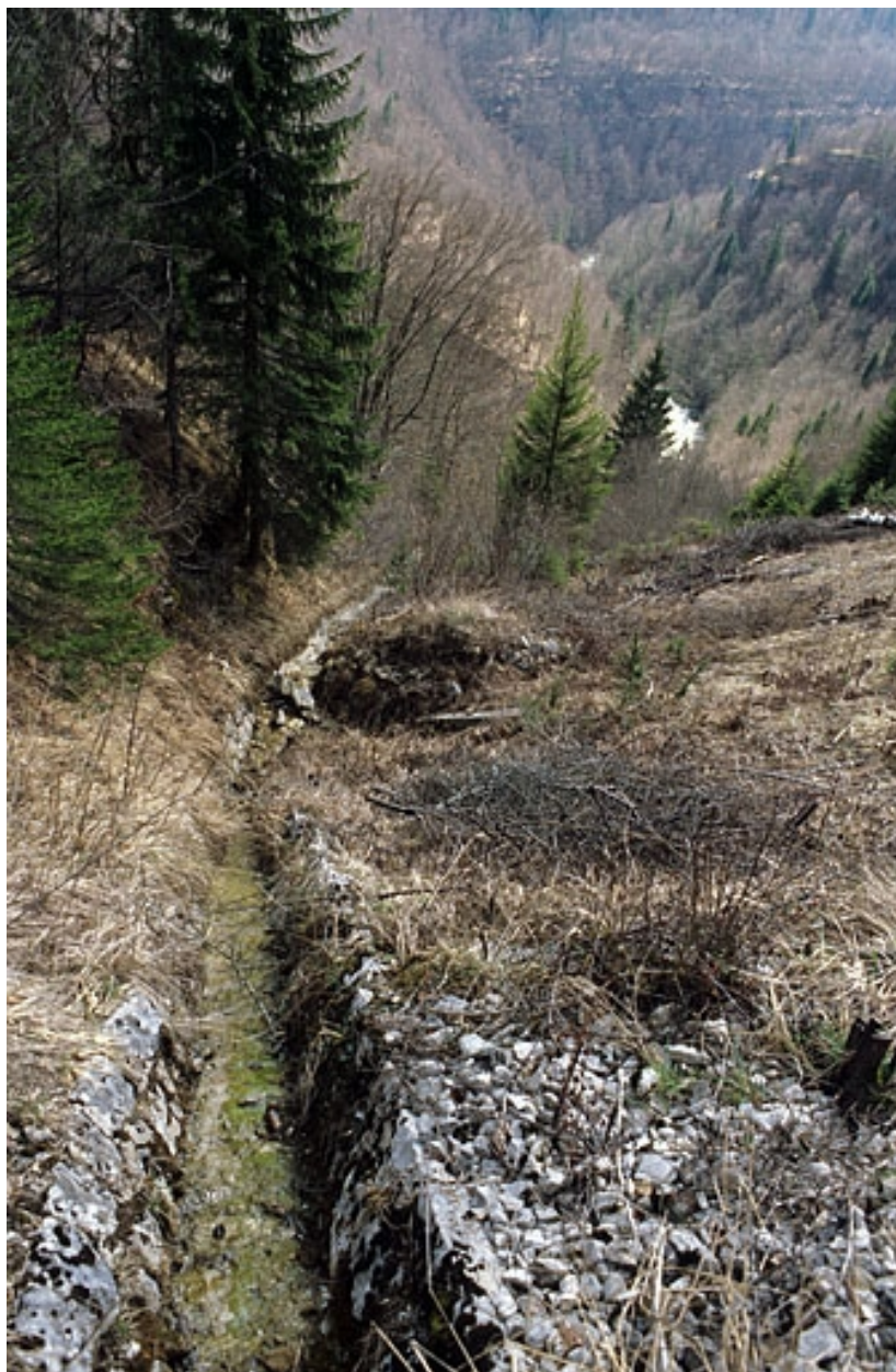
Tunnel : rigole d'évacuation d'eau de la tête côté La Cluse.
