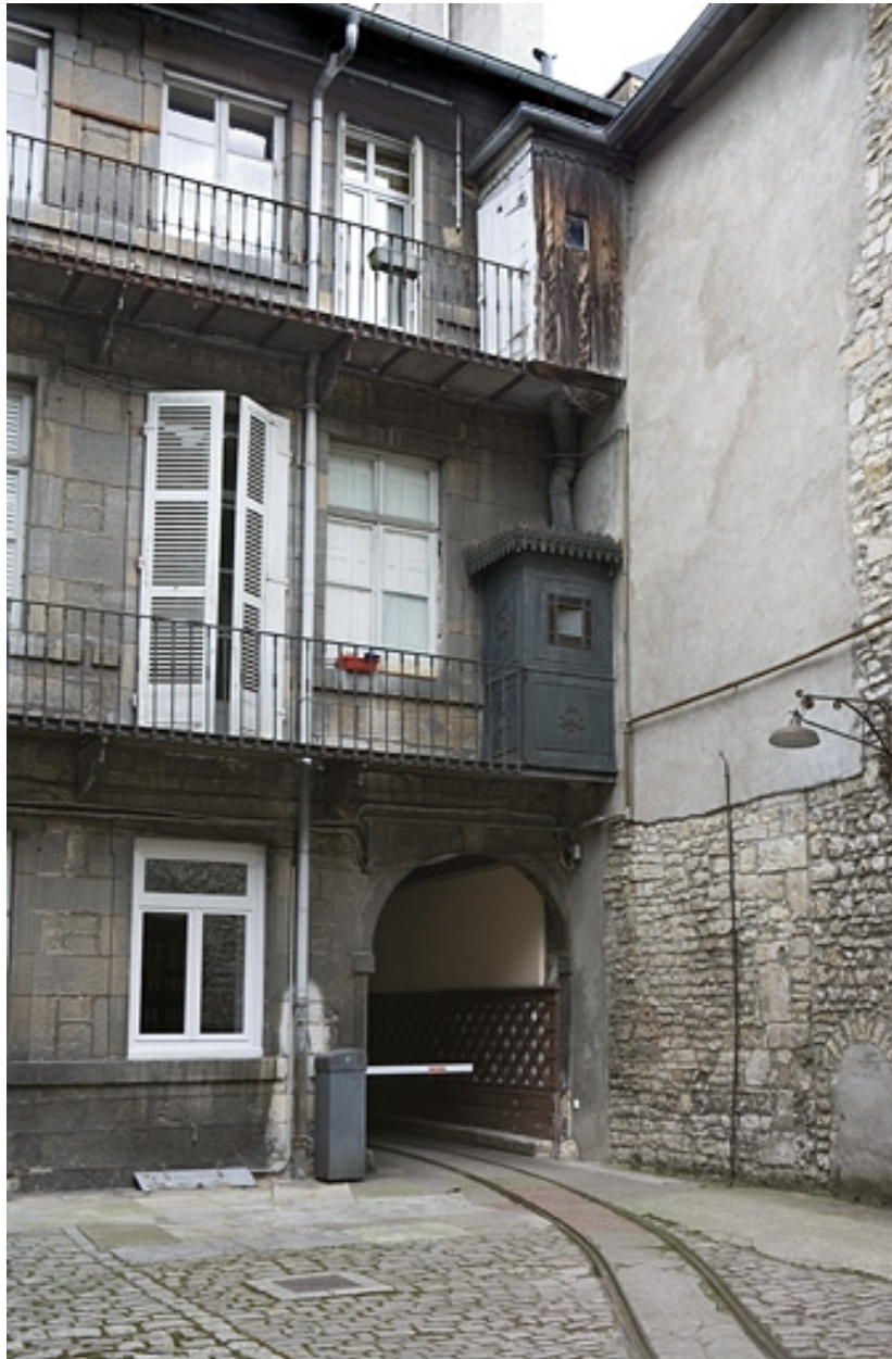
Façade postérieure du logis sur rue : détail des anciennes latrines au-dessus du portail d'entrée.
