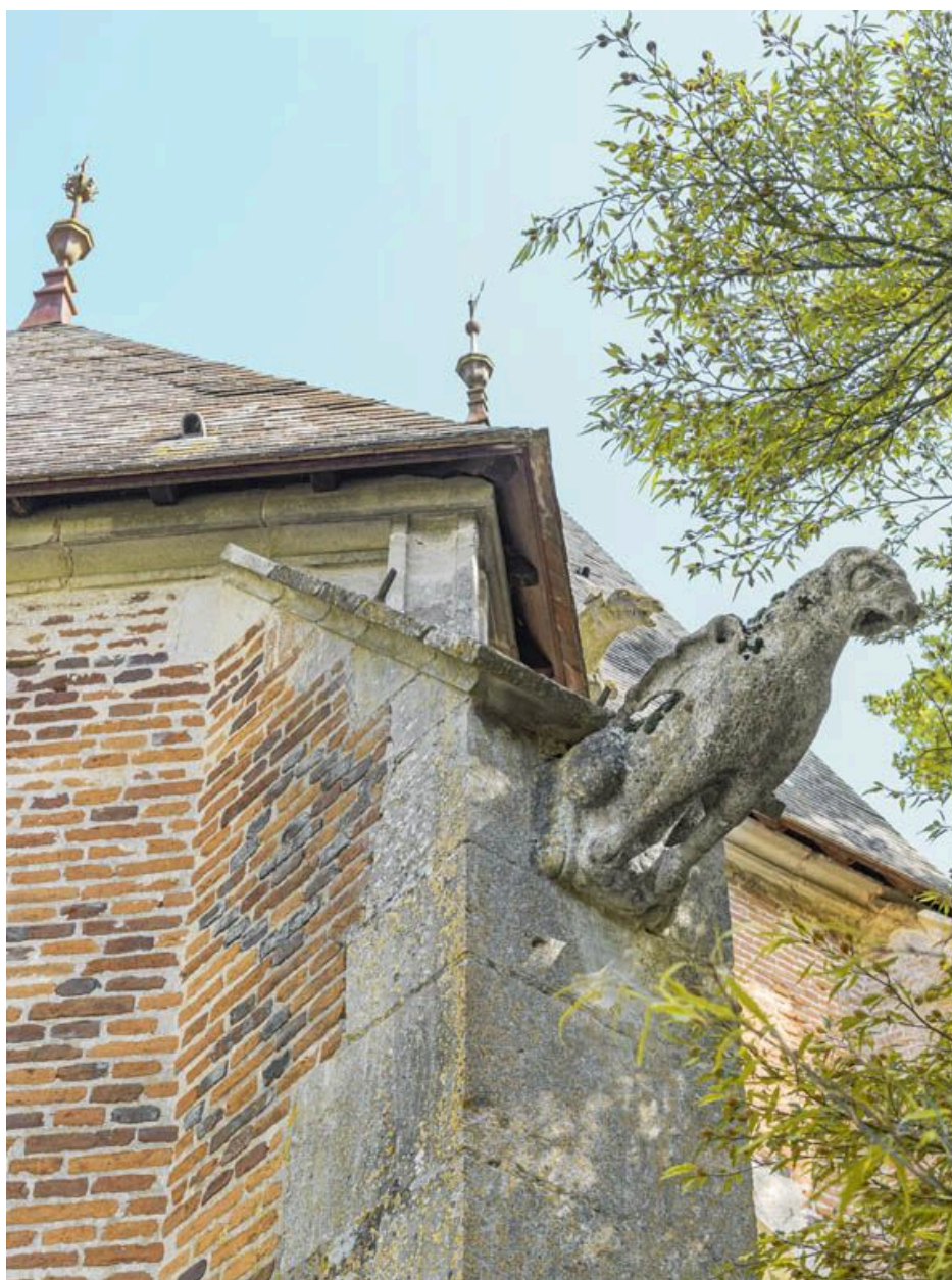
Gargouille sur un contrefort de la chapelle gauche.
