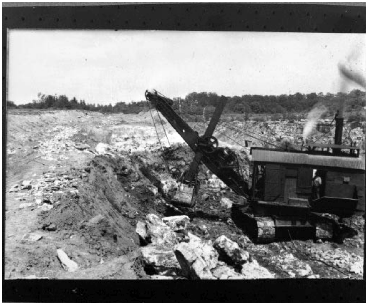
Excavatrice à vapeur Bucyrus, vers 1930.
