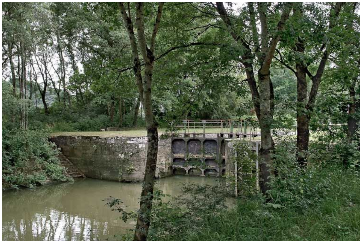
La tête aval de l'écluse.
