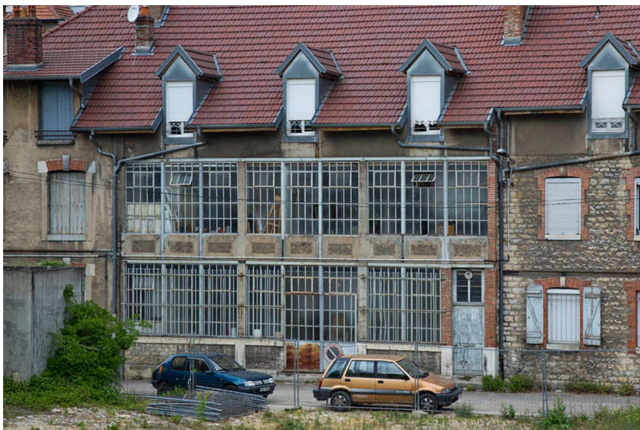
Façade postérieure de l'atelier de fabrication.
