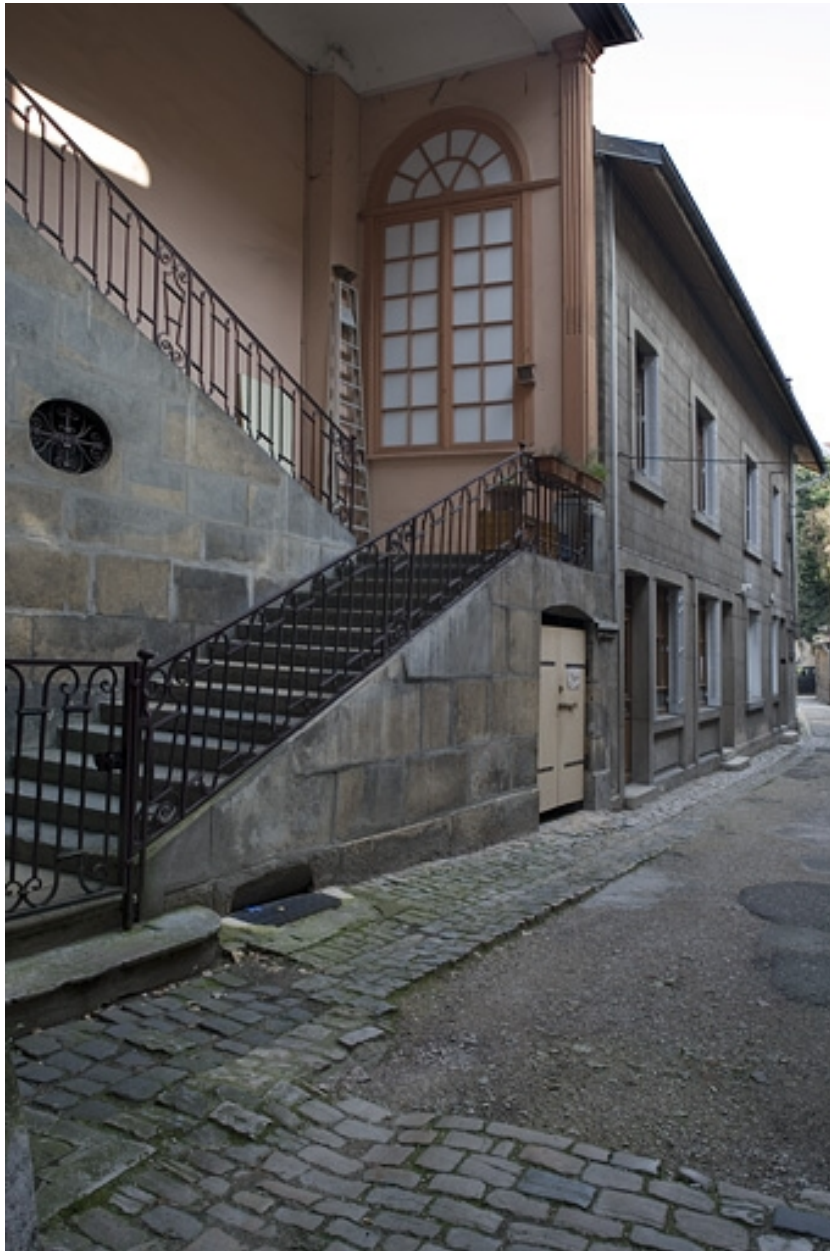
Vue d'ensemble de l'escalier extérieur dans la deuxième cour.
