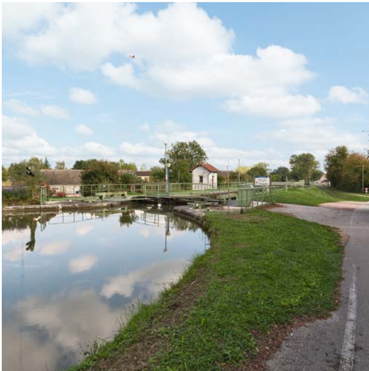
Vue d'ensemble du site d'écluse.
