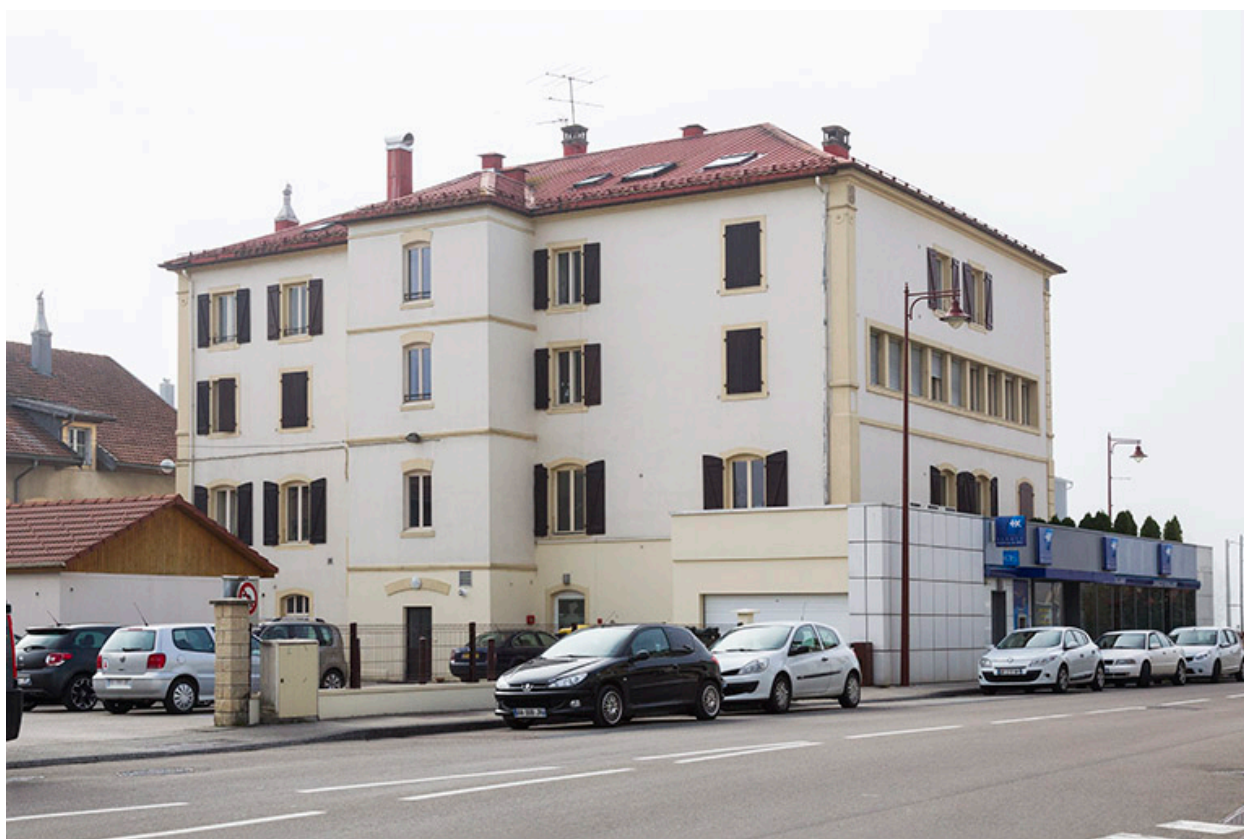
Façades postérieure et latérale gauche.
