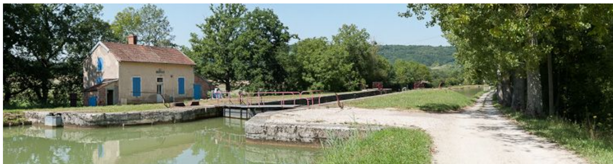
Vue du site d'écluse depuis l'amont.
