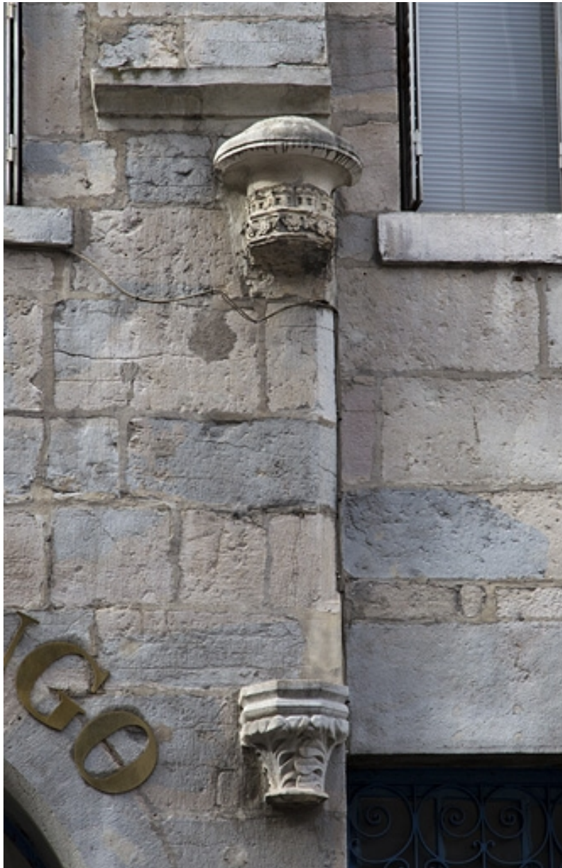
Façade antérieure : détail du décor.
