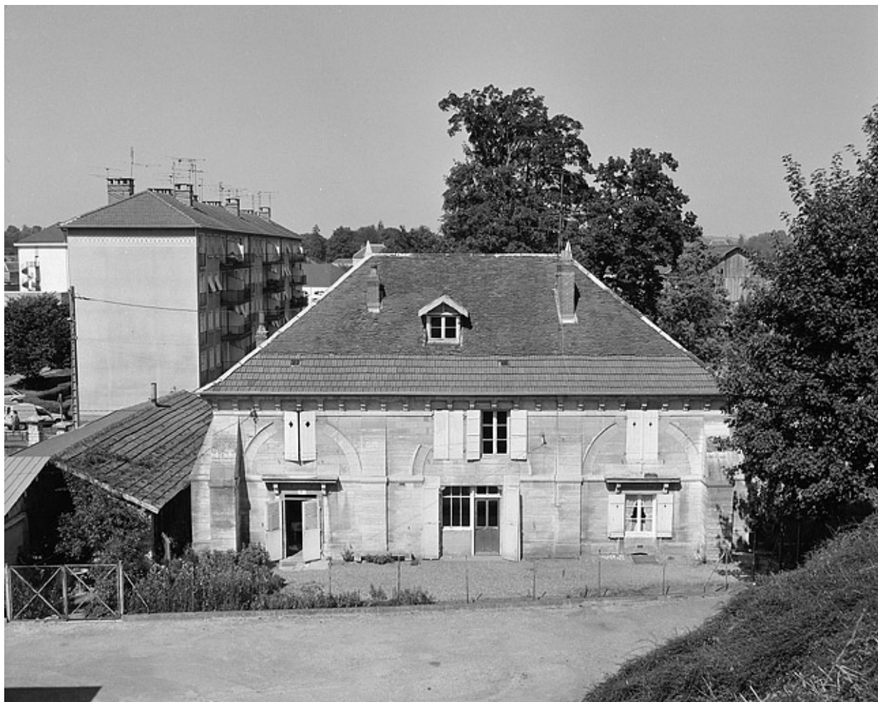
Façade antérieure, de face.
