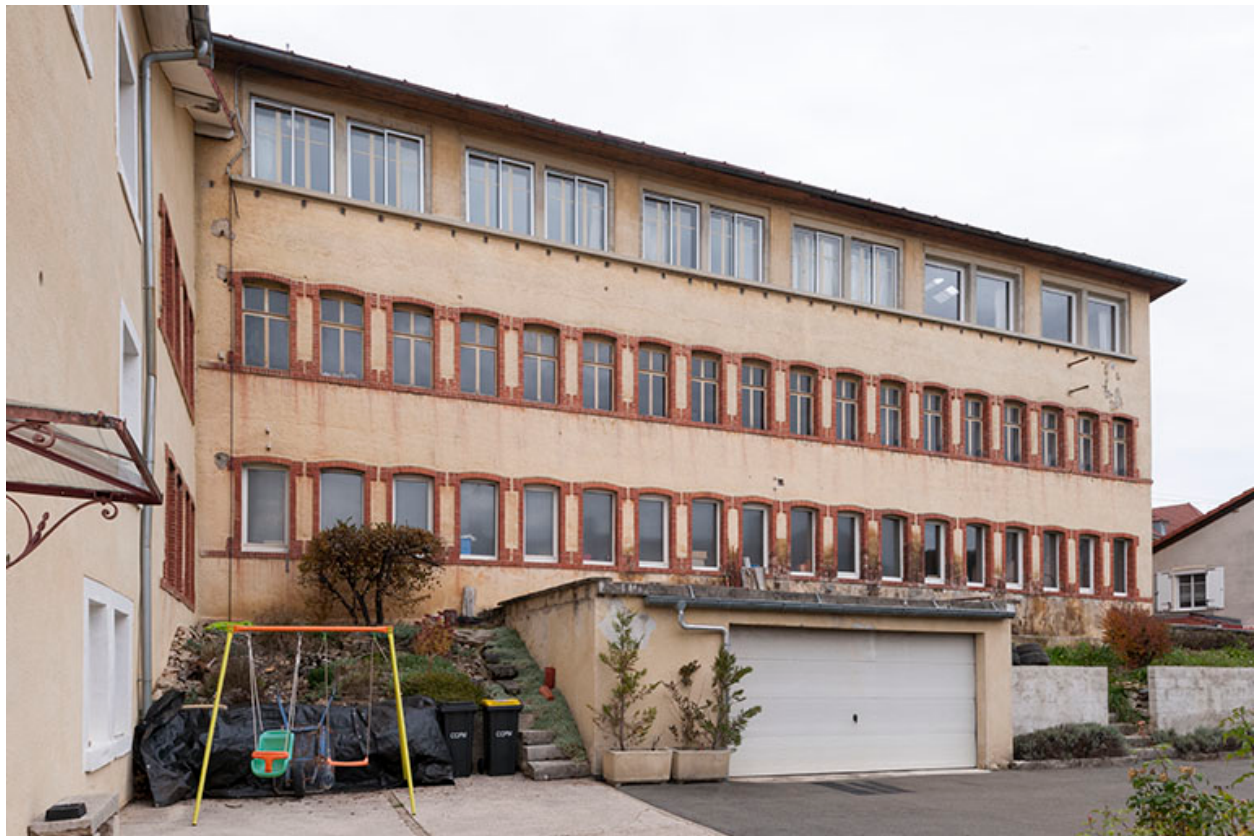
Usine : façade antérieure (sud).
