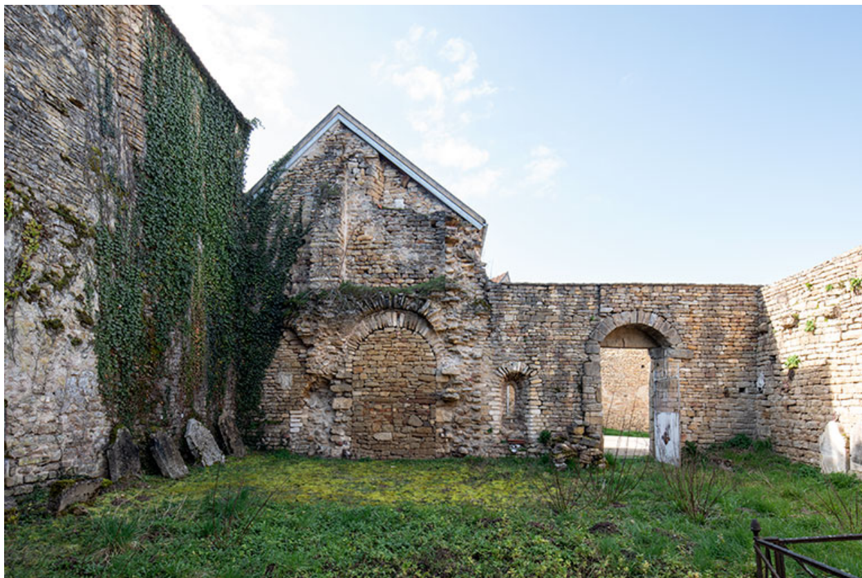
L'ancienne église, en direction de l'ouest.
