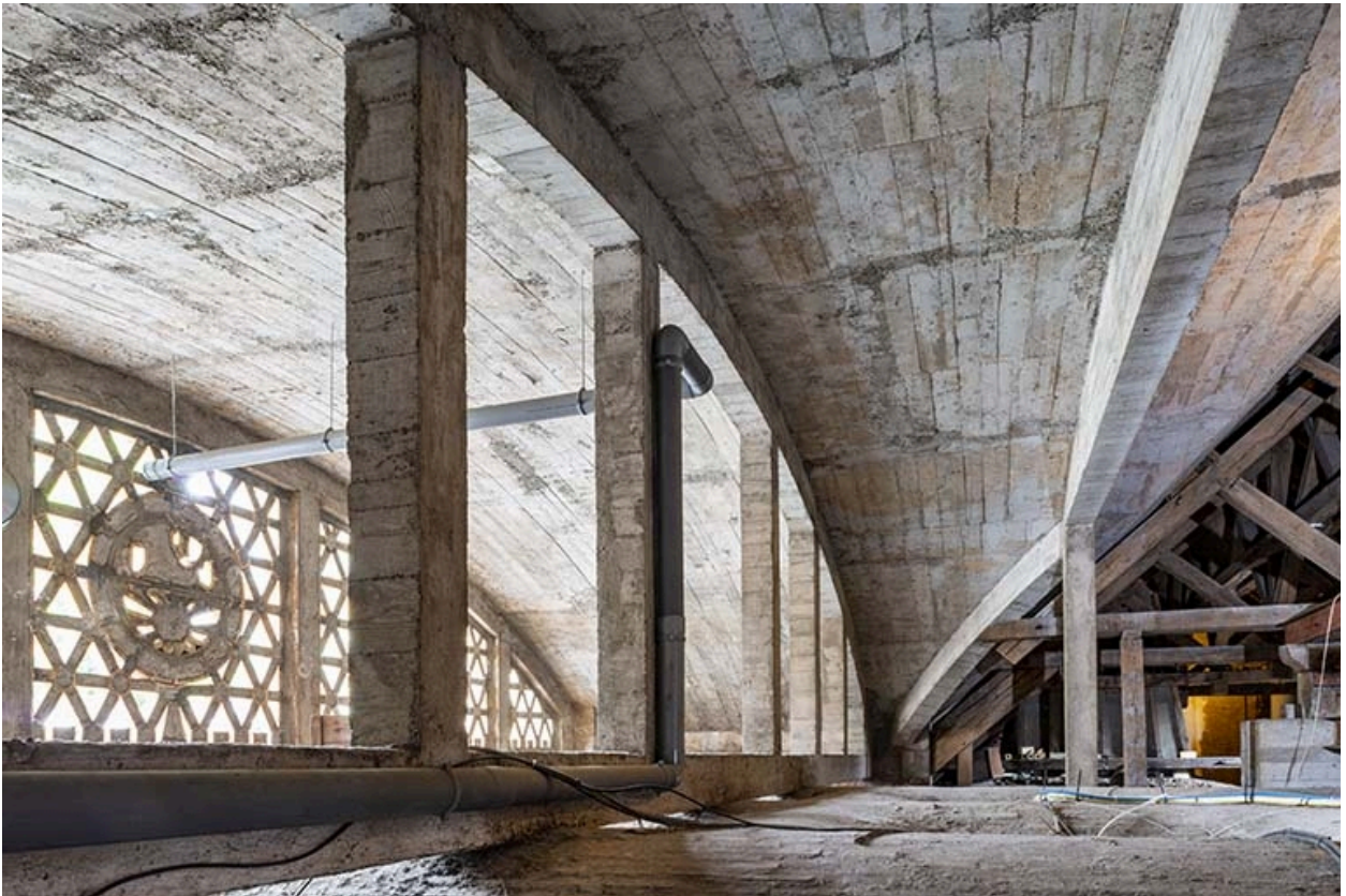
Fronton de la façade nord, vue intérieure.
