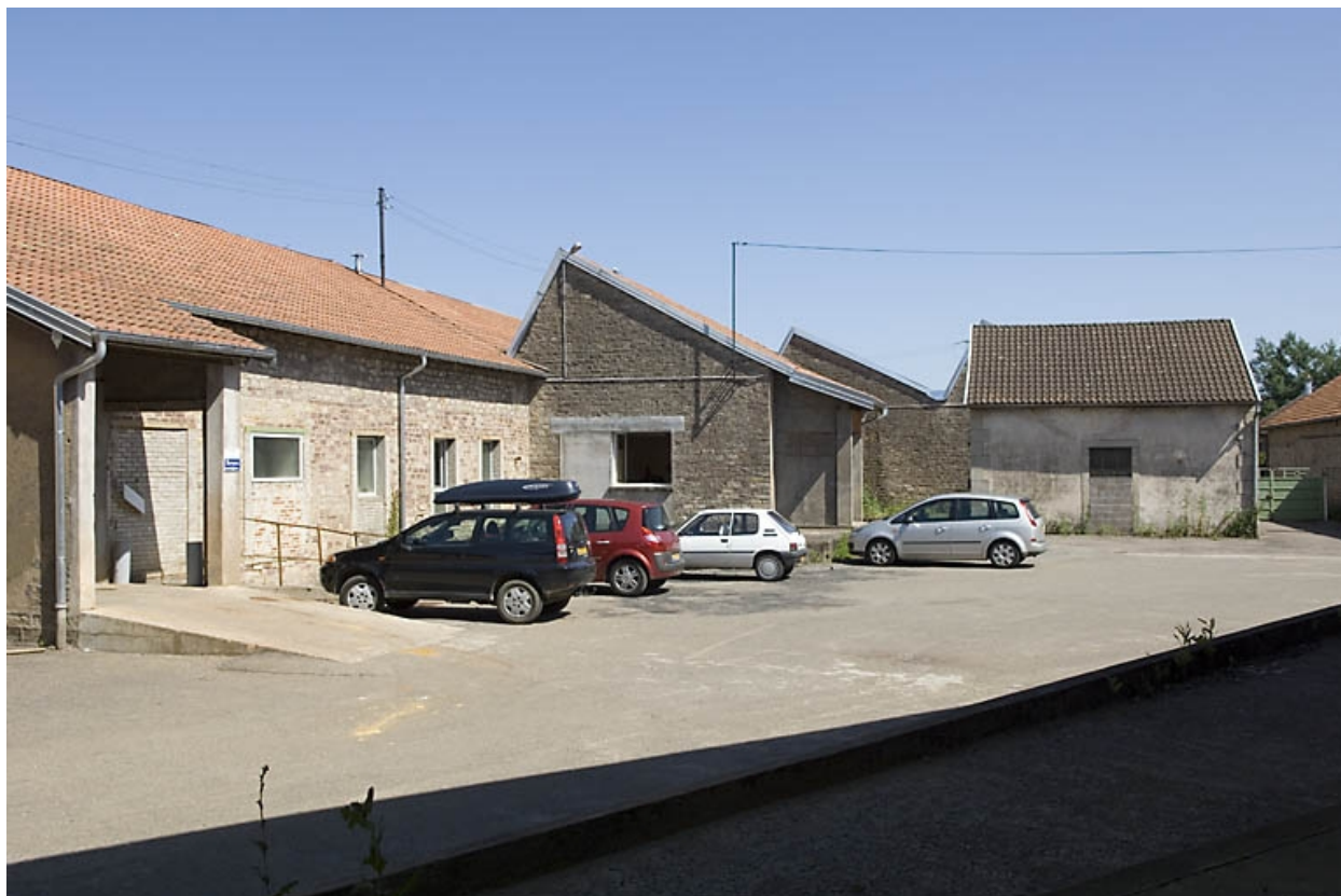
Bâtiments ouest (stockage).
