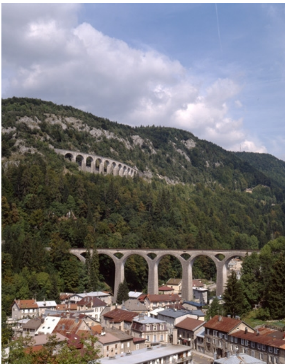
Le grand viaduc, avec celui des Crottes en arrière-plan.
