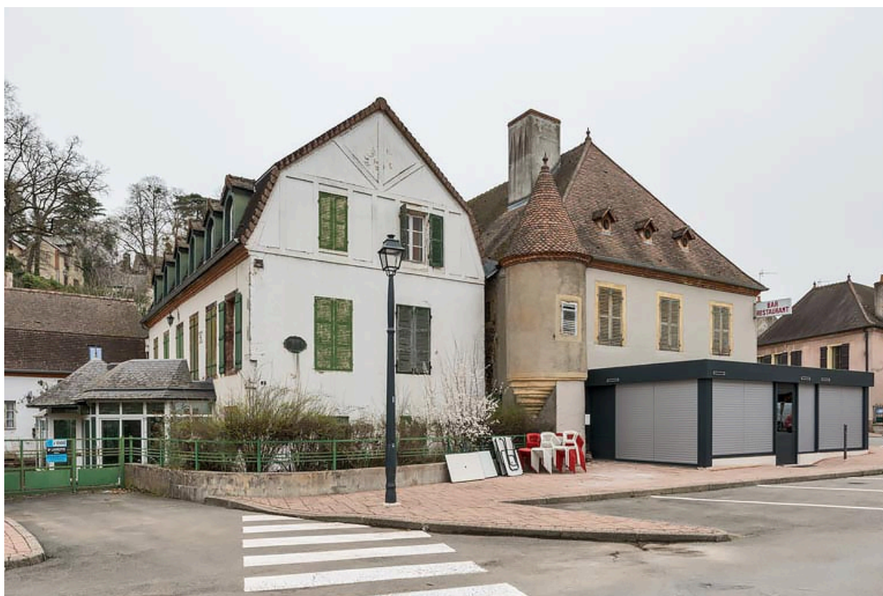
Vue actuelle depuis l'ouest.
