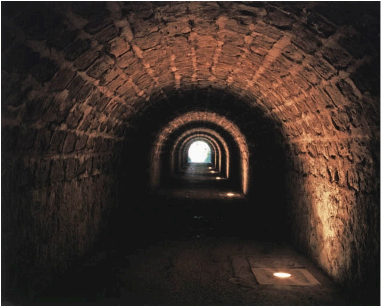
Passage souterrain (sous les voies) : intérieur.
