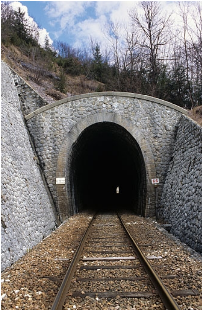
Tunnel des Frettes : tête côté La Cluse (sud).
