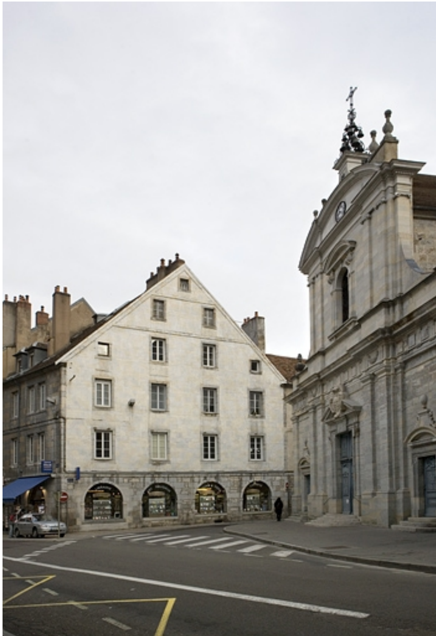
Vue d'ensemble de la façade latérale du logis principal de trois quarts droit.
