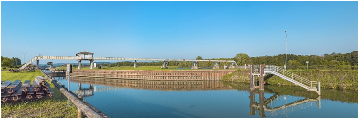
Tête amont de l'écluse.
