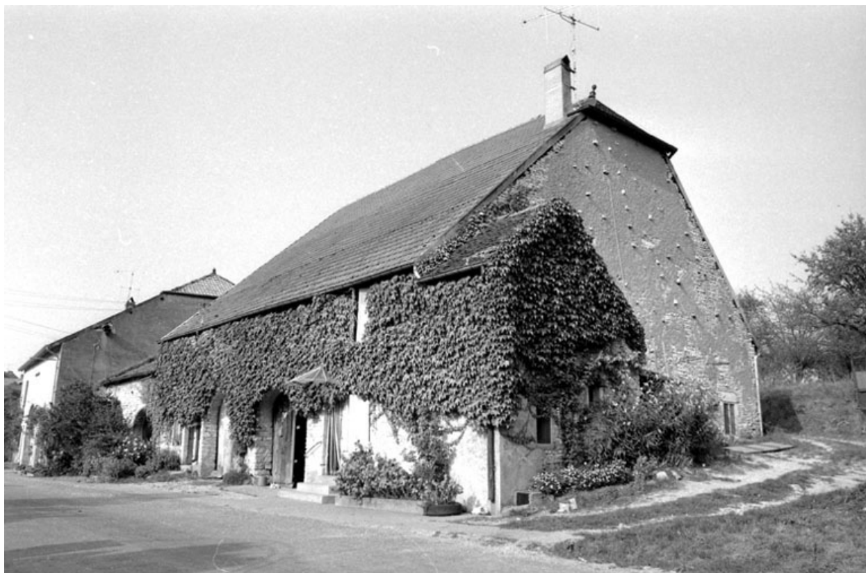
Façades antérieure et latérale droite.
