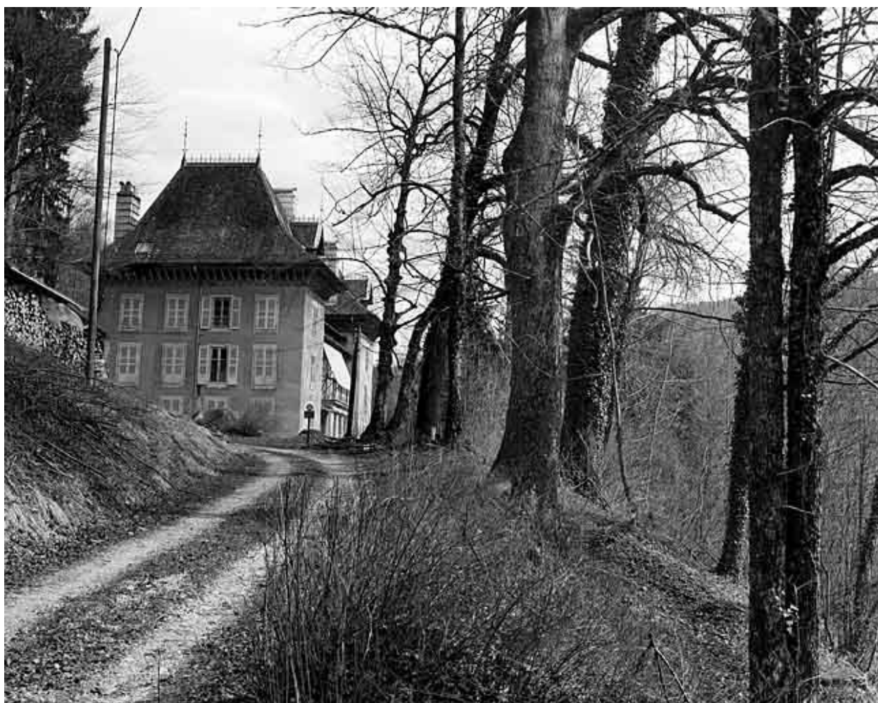
Vue d'ensemble rapprochée, depuis l'ouest.
