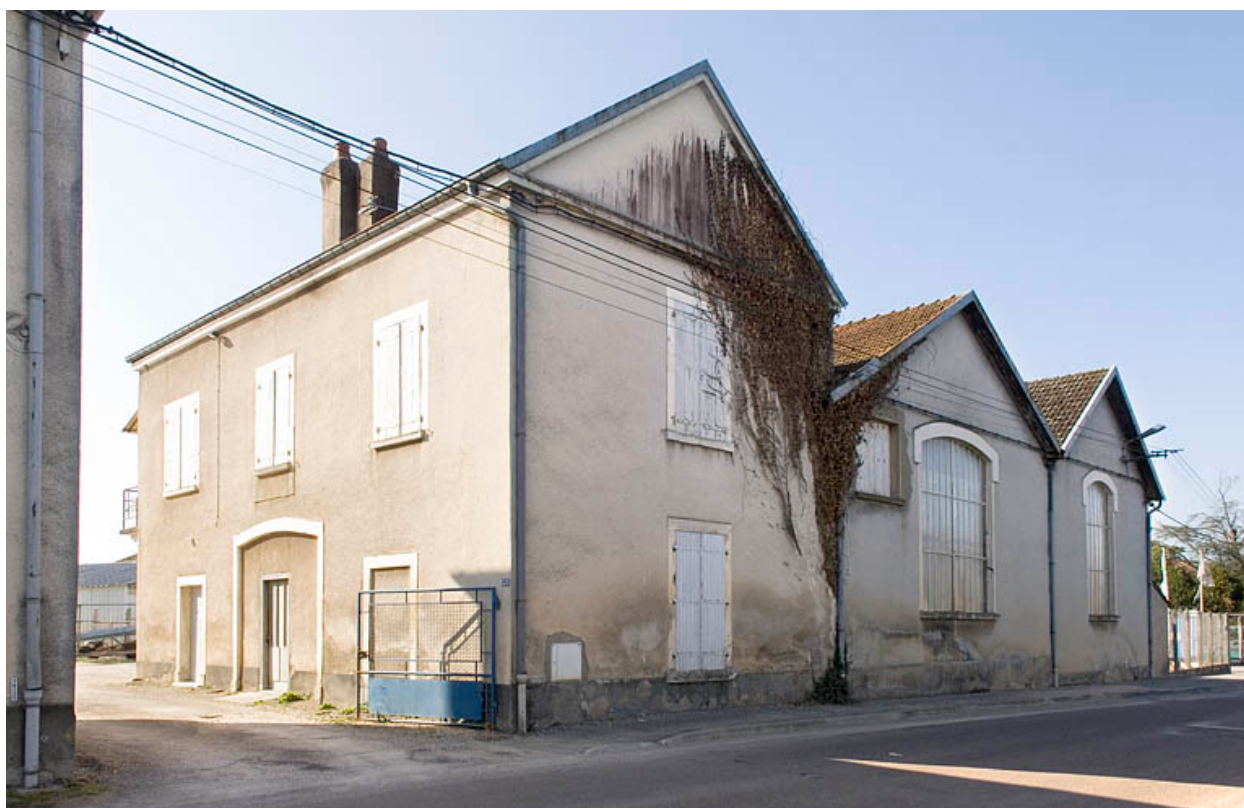
Bâtiments industriels. Logement, entrepôt et atelier.
