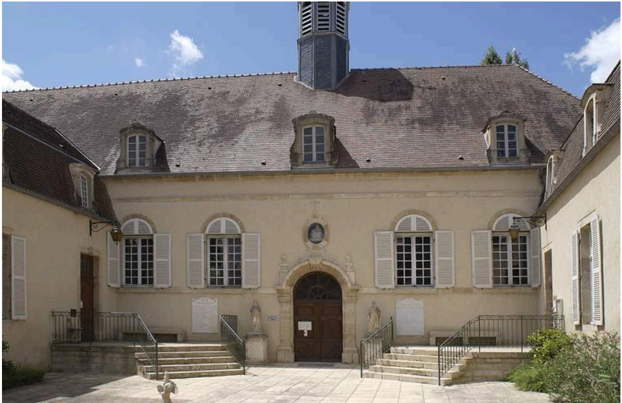
Corps central de la façade principale.
