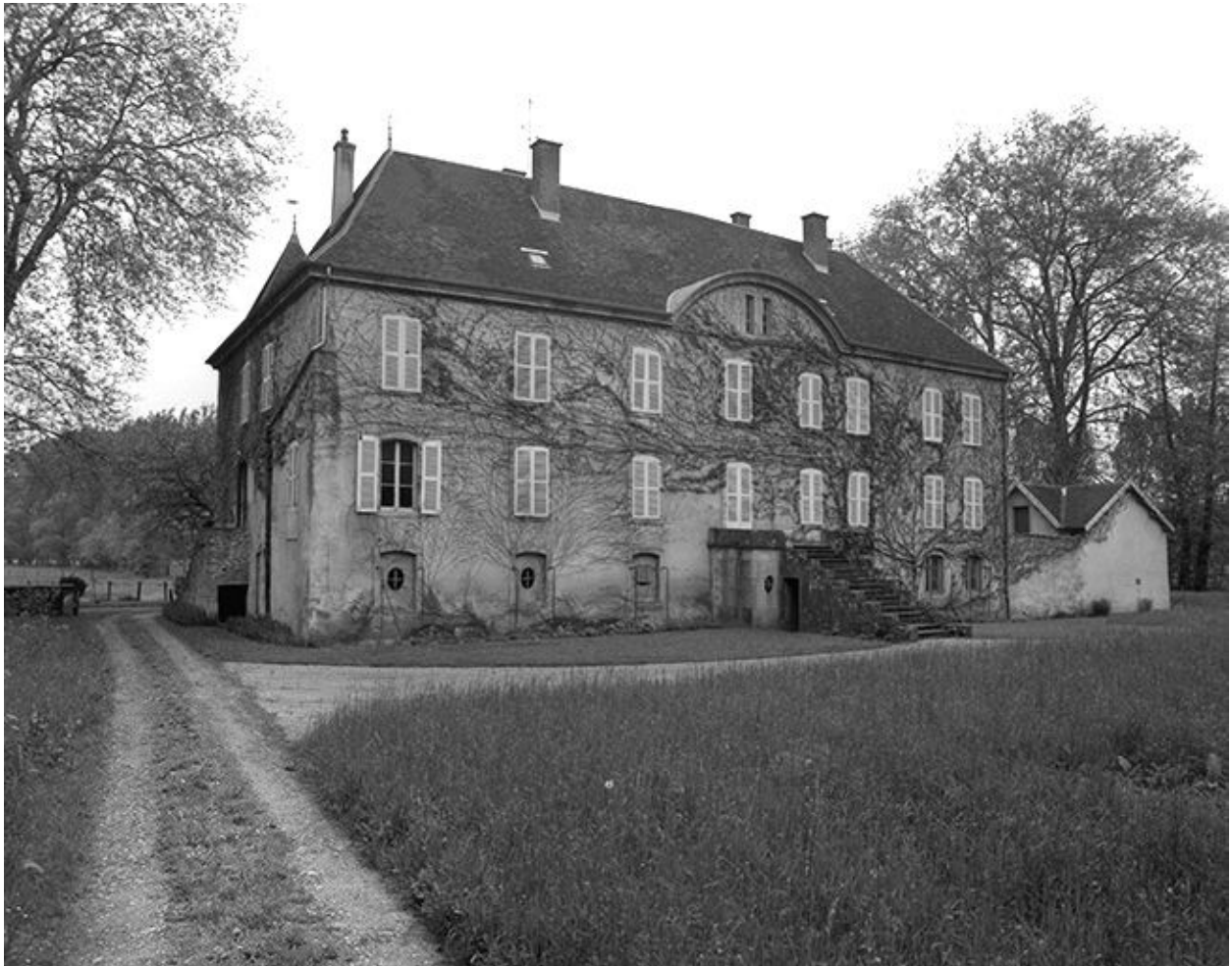
Façade principale, vue de trois quarts.
