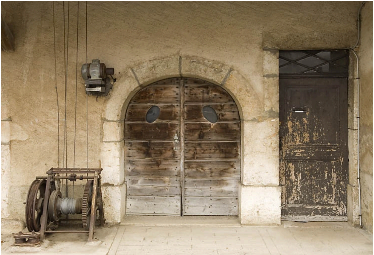
Façade antérieure : portes de l'étable et de l'habitation.
