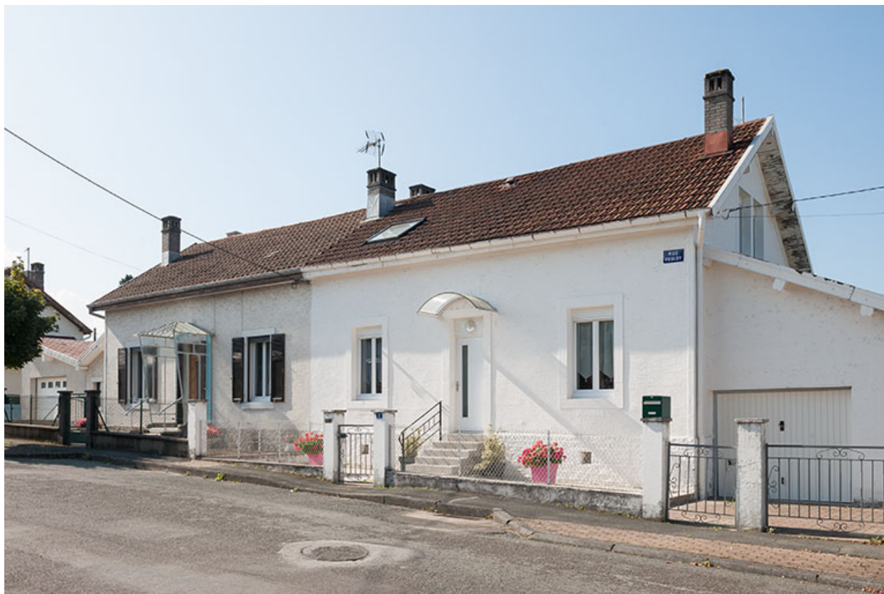
Maison jumelée vue de trois quarts droite.
