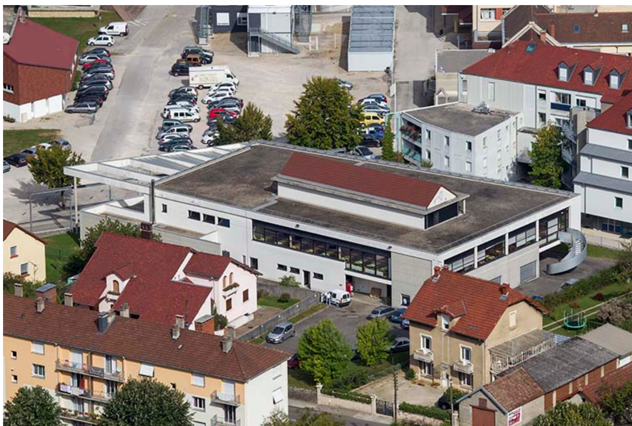
Internat-restauration : vue générale du site.
