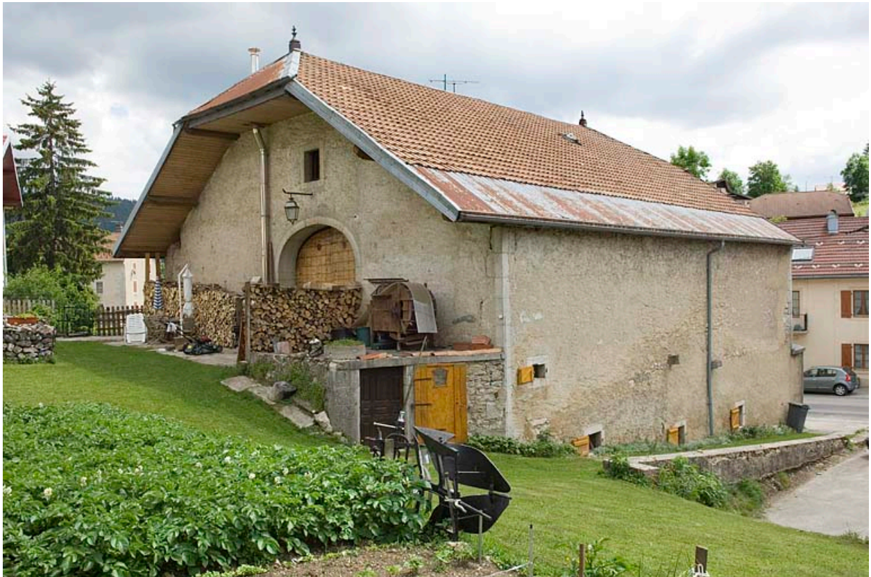
Façade postérieure et façade latérale gauche.
