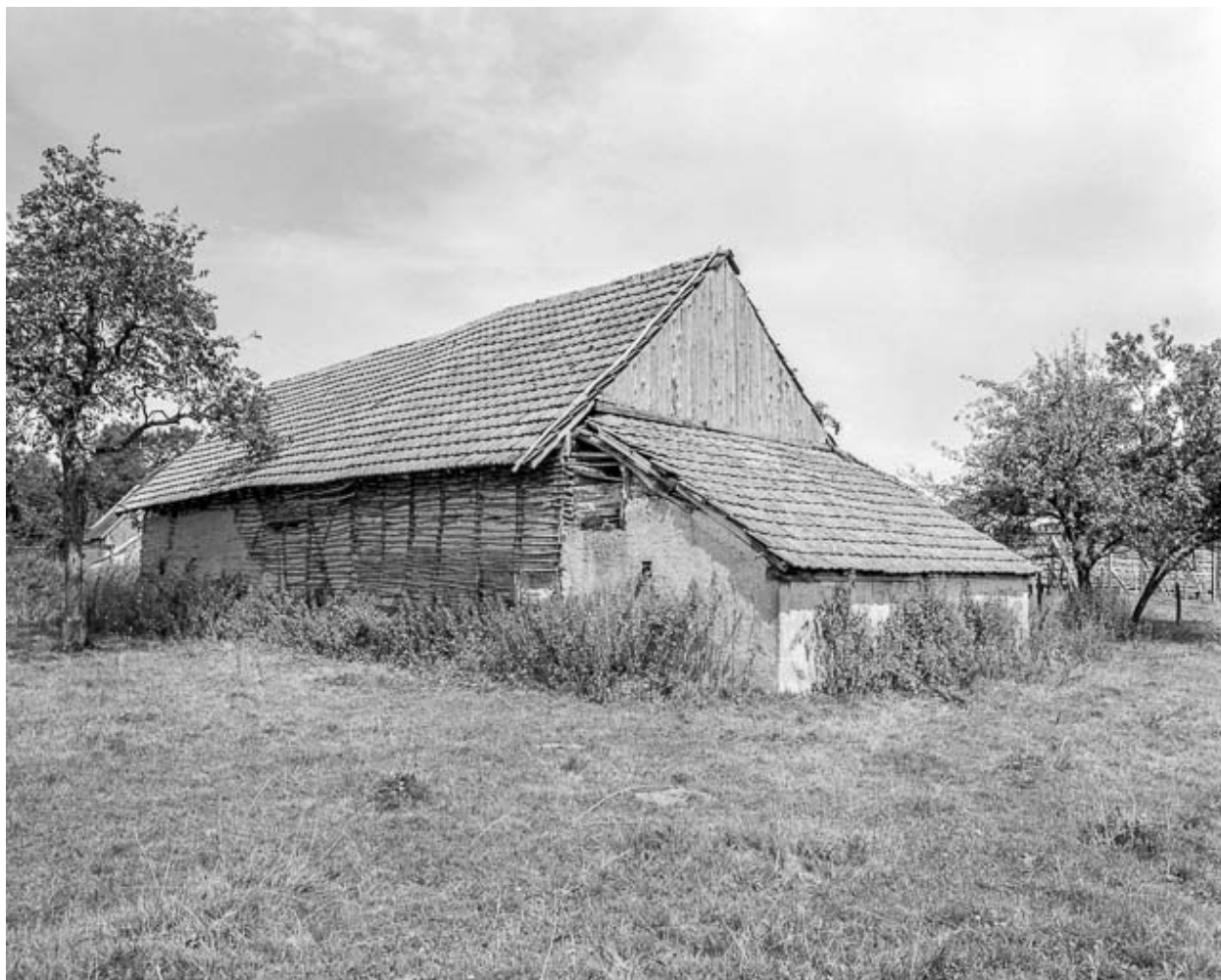
Ferme cadastrée 1963 AB 20 : façade postérieure.
