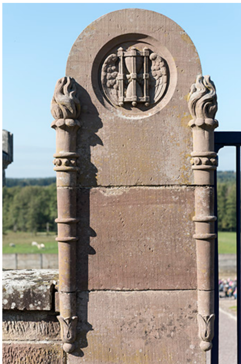
Détail du pilier gauche du portail d'entrée.
